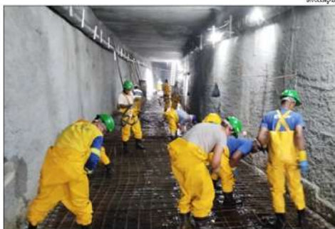
ETAPA é fundamental dentro das obras de recuperação da estrutura do túnel
